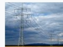
Die Seile von Freileitungen folgen der Kettenlinie
